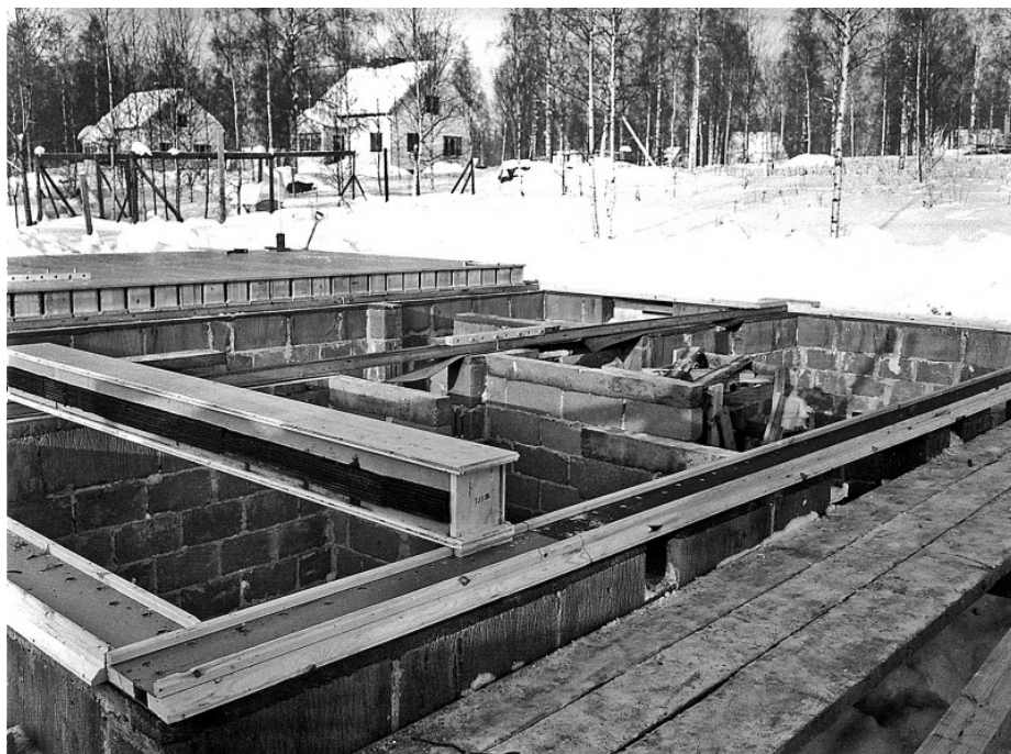
Montage av bjälklagselement påbörjad till en villa. Ingen kran behövdes till de hanterbara bjälklagselementen.
