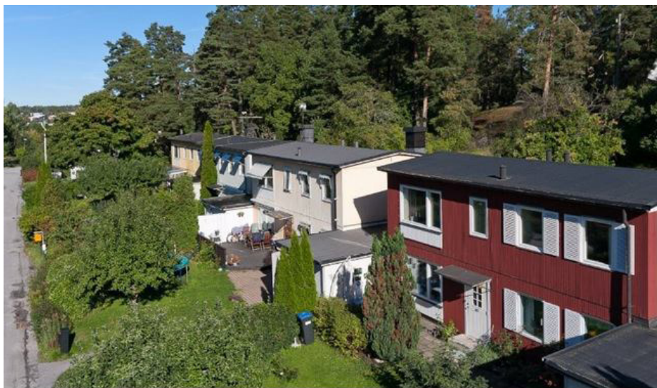
Kedjehus i Täby, norr om Stockholm. Husen är i gott skick och är några av cirka 18000 Elementhus som byggdes under perioden 1952 - 1972.
