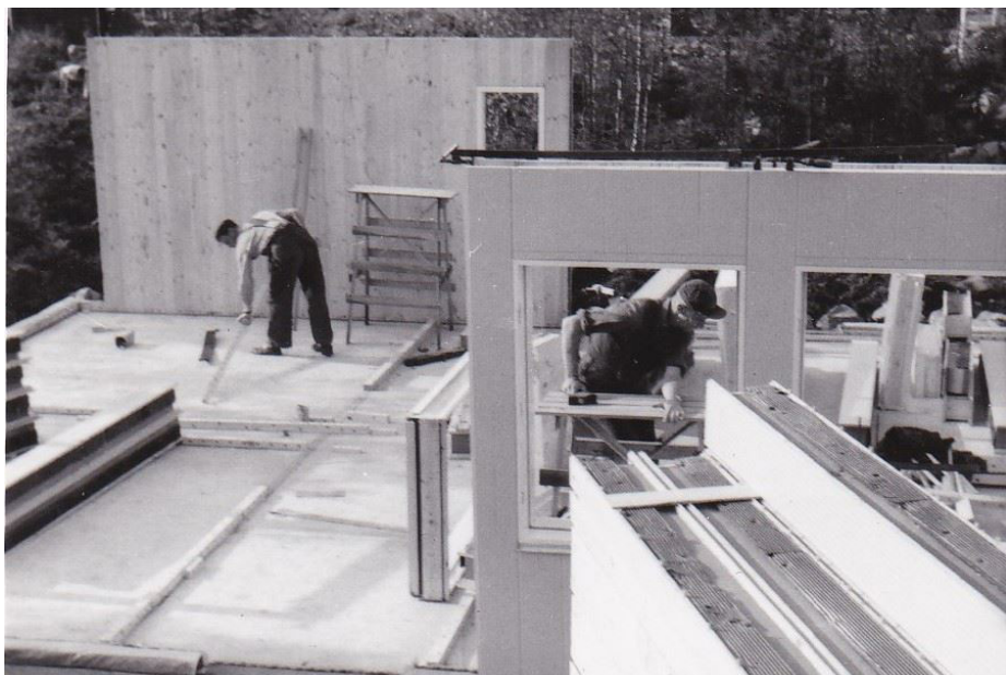
Ett elementhusbygge någonstans i Sverige. Byggtid cirka 12 dagar med 4 montörer.
