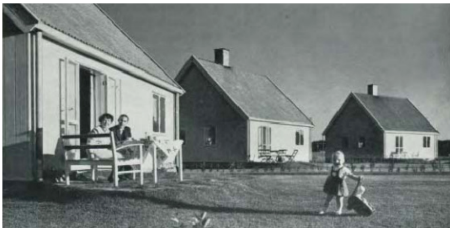
Några av de första husen tillverkade av AB Elementhus i Mockfjärd.
